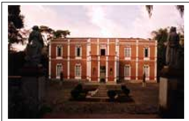
Imagem 1- Fachada principal do MMP
