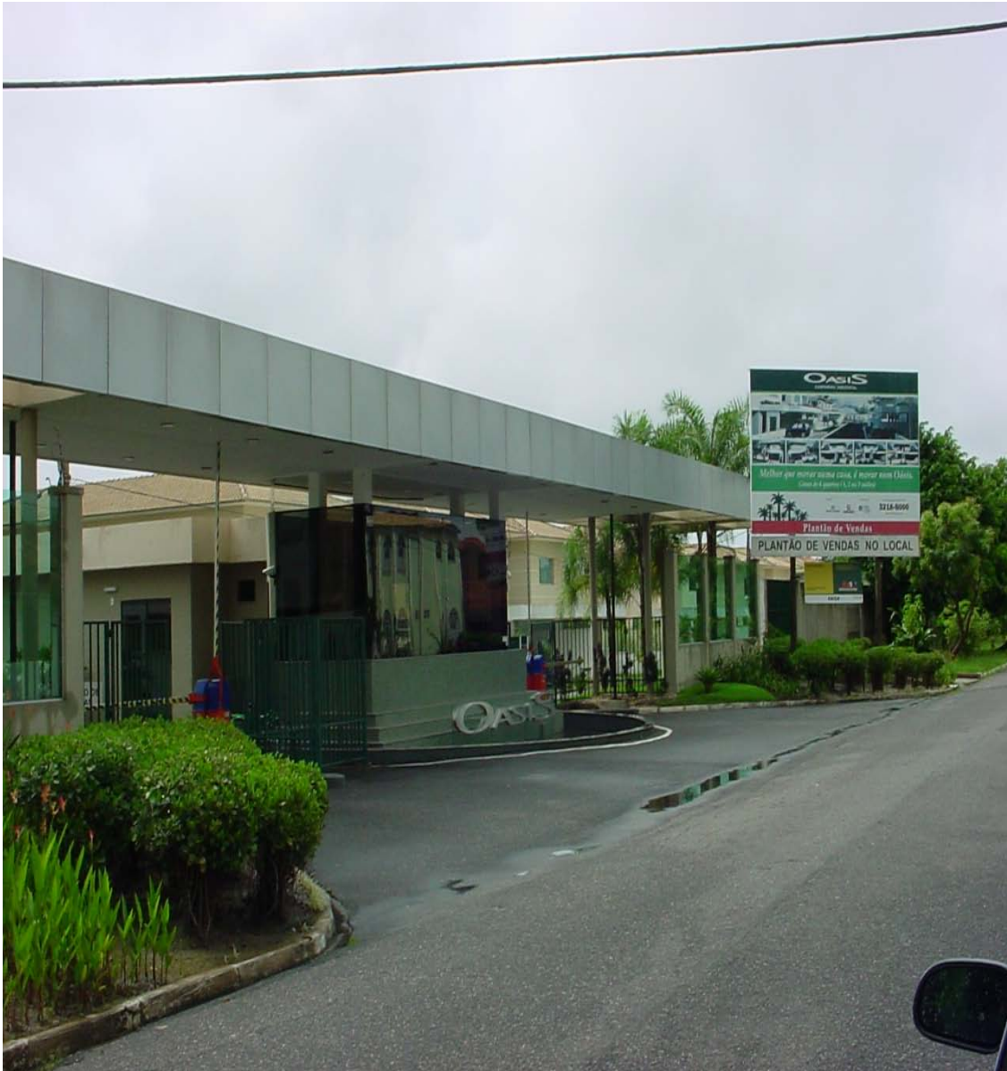
Fig. 02 - Condomínio Horizontal no bairro do Benguí. Fonte: Pesquisa de Campo.
