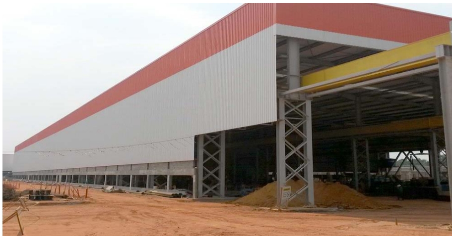
Galpão em Estrutura Metálica (em construção). Fonte: FAM Estruturas Metálicas
