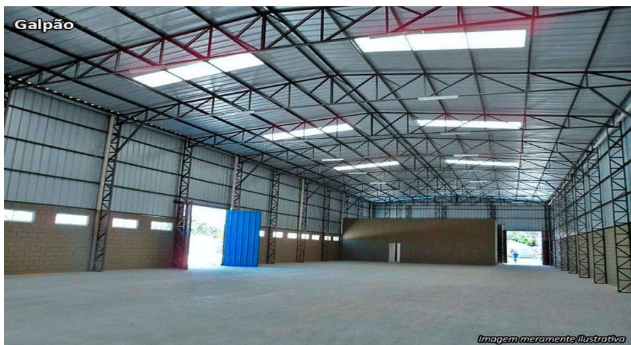
Galpão de Estrutura Metálica. Fonte: Projeto
